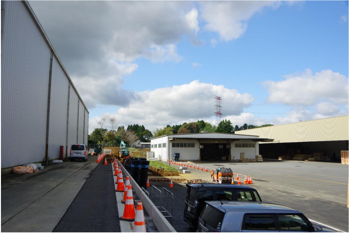
成田南部第2・第3物流センターを結ぶスロープ工事中
