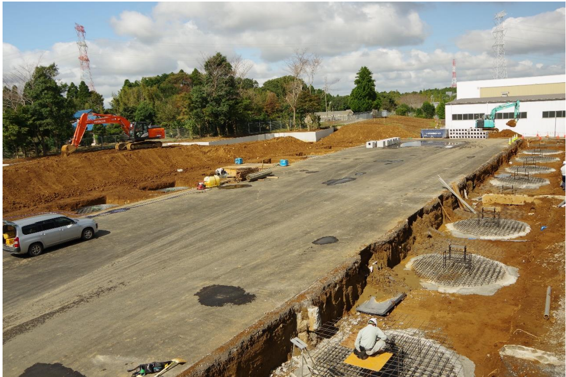
2022年2月業務開始予定の新設倉庫における基礎・擁壁工事を行っています。
