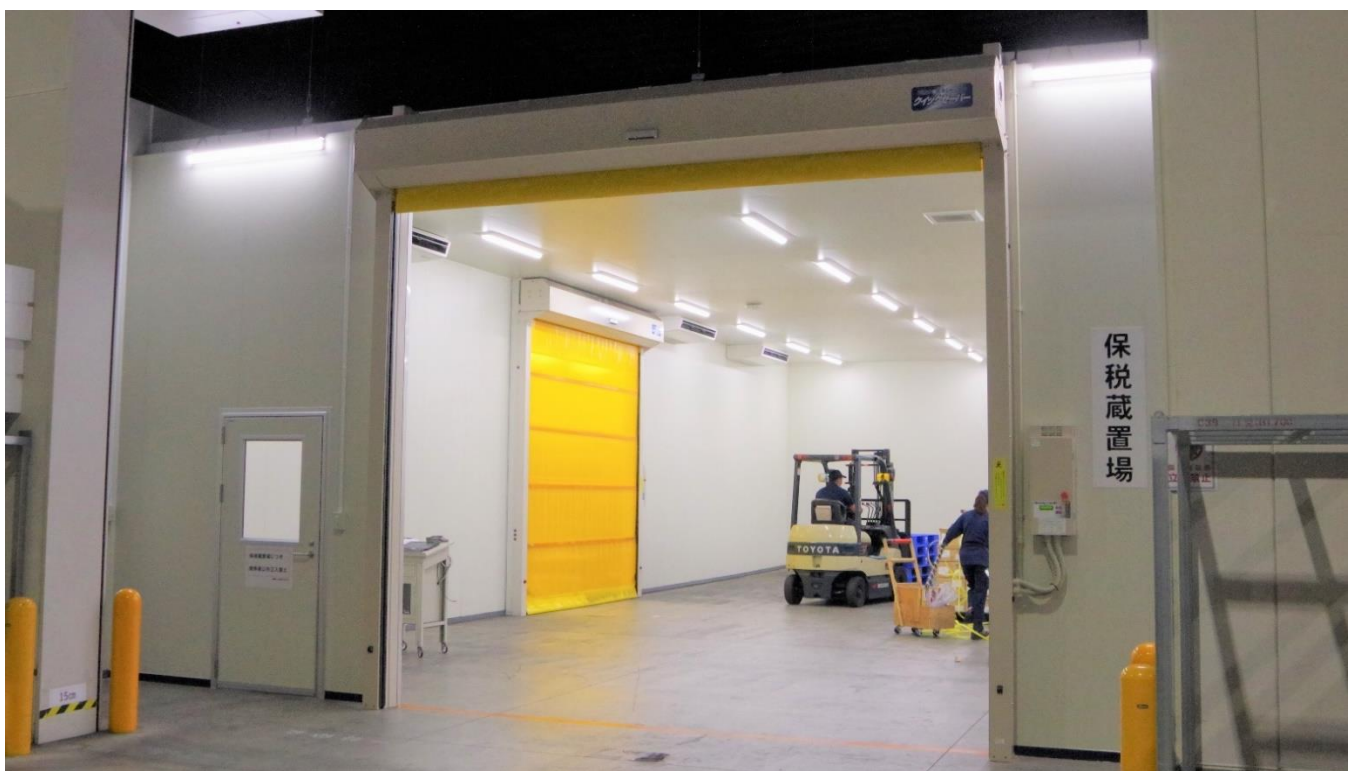
新設した空調庫第 1・第 2
