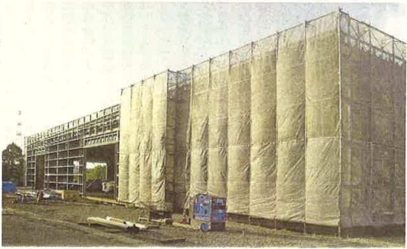
建設中の成田南部物流センター
