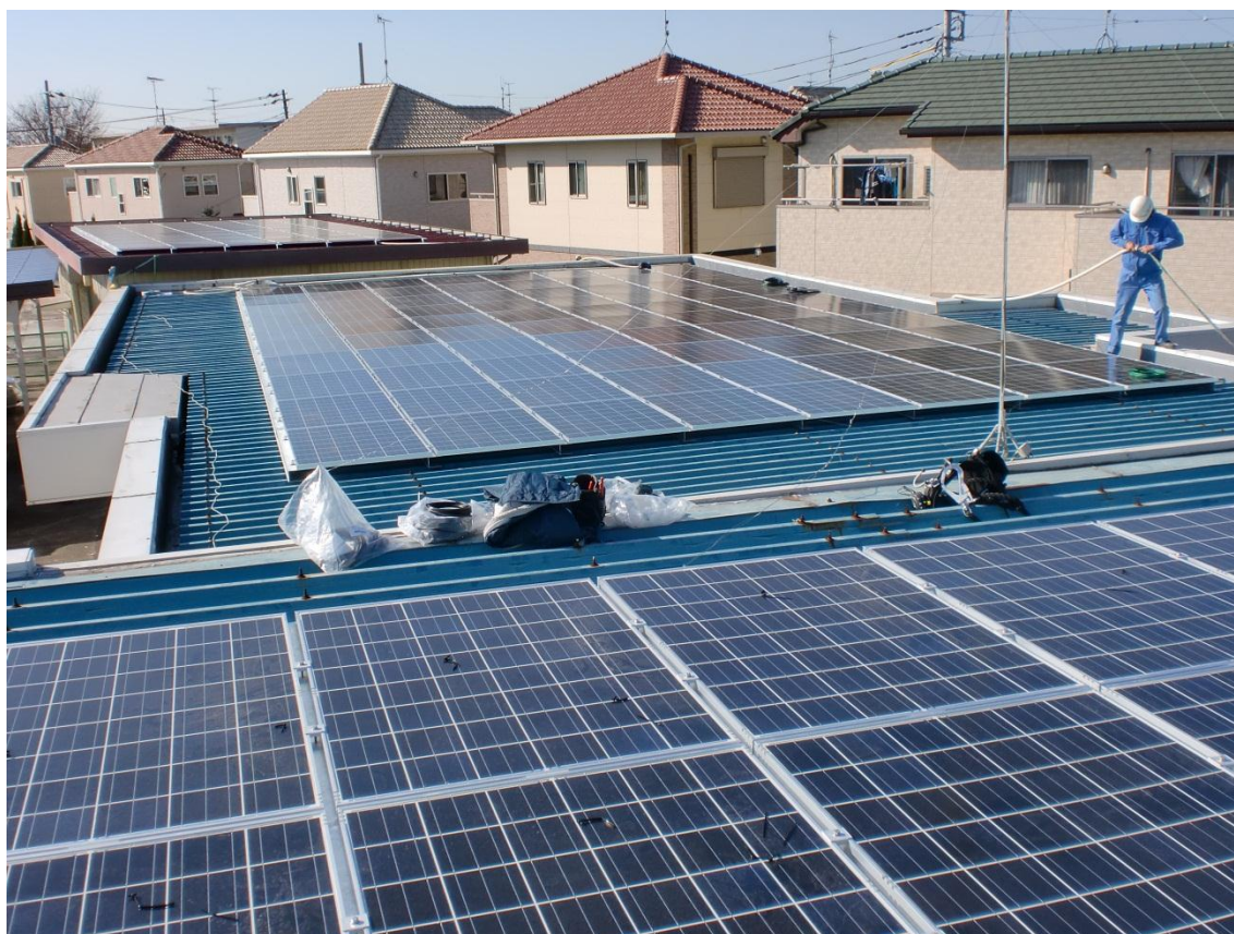
太陽光パネル設置作業風景
